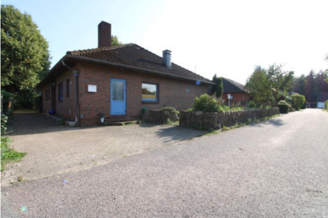
Straßenansicht mit Hintereingang
